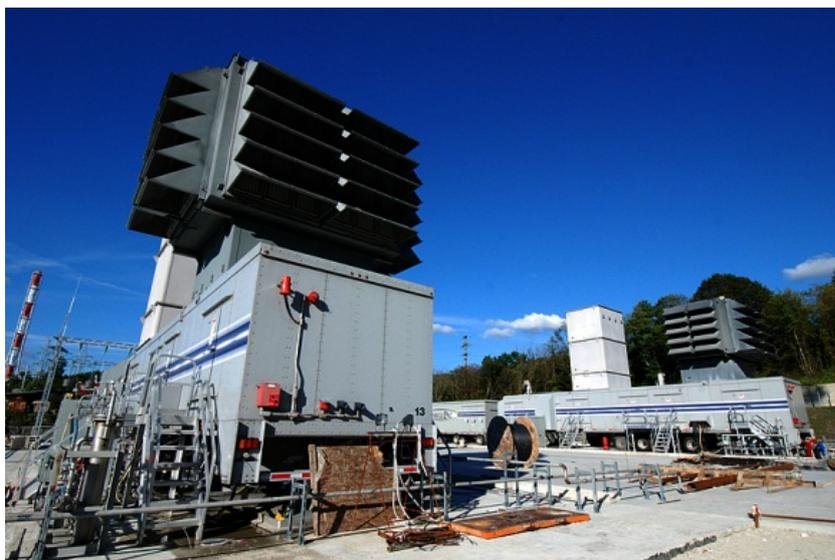
Рисунок. 1 – Мобильная газотурбинная электрическая станция
