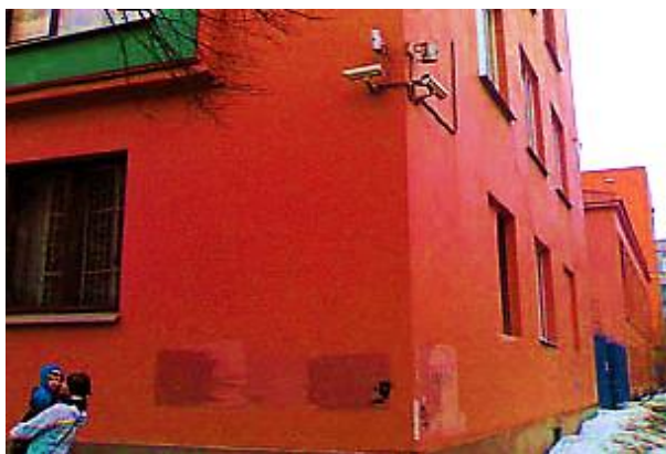
Рис. 5.18. Ошибочная установка камеры на стене здания
