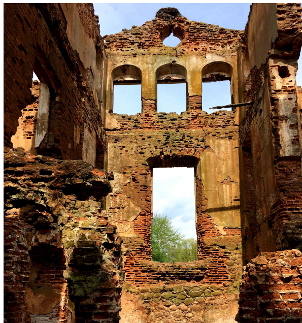
Рис. 1. Сохранившаяся часть строений с бутовой кладкой
