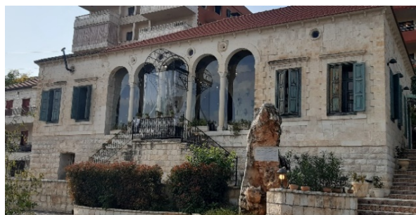
Фасад жилого дома в г. Набатия
