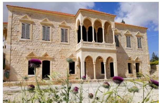
Рис. 3. Жилой дом 1905 г. строительства в г. Адайси после реконструкции. 2019 г.
