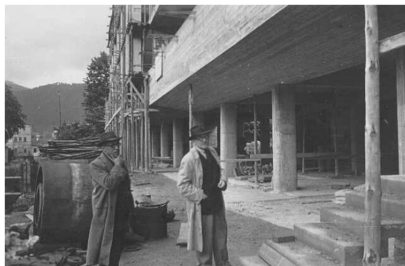
Рис. 4. Мануфактура Клод и Дюваль в Сен-Дье, Франция, процесс строительства, арх. Ле Корбюзье.
