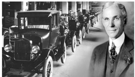
„Tin Lizzy“ war der gelungene Auftakt für die Produktion von Automobilen nach den Prinzipien der Massenfertigung. In Fords neuen Fabriken erfolgte die Fertigung nach einem völlig neuen System: mit standardisierten Einzelteilen, in viele kleine Schritte zerlegt und mittels Fließband vielfach beschleunigt.
