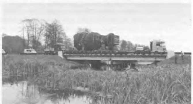
Рис. 3. Общий вид пропуска сверхнормативной нагрузки по мосту
