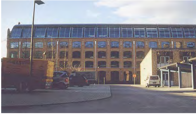
Рис. 2.45. Использование современных материалов при реконструкции исторического производственного здания (г. Берлин)
