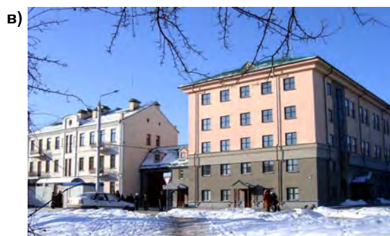
Рис. 2.36. Реновация промышленных объектов: а, б – многофункциональный жилой комплекс (г. Вена). Реновация газгольдеров 19-го века в промышленном районе Зиммеринг; в – банковское здание (г. Гродно). Реновация завода «Электроприбор»
