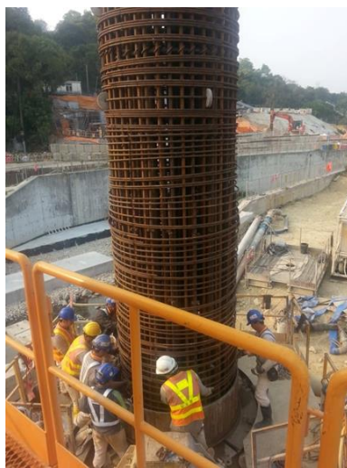
Рисунок 2 – Установление каркаса
