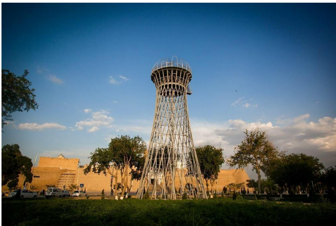
Рисунок 1 – Общий вид конструкций водонапорной башни в г. Бухара до восстановления
