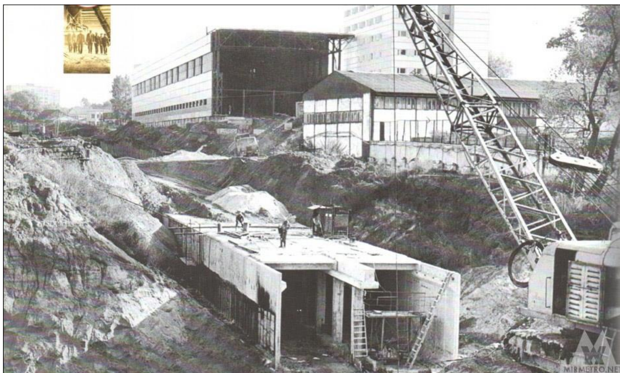
Рисунок 1 – Строительство станции «Первомайская»
