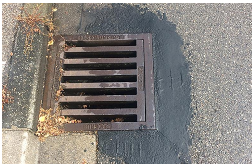
Рисунок 2 – ChipFill спустя два года
