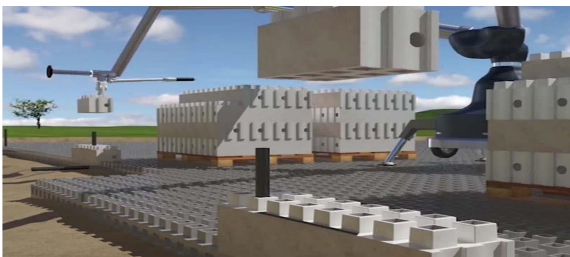
Рисунок 4 – Пример установки блоков SmartBrick
