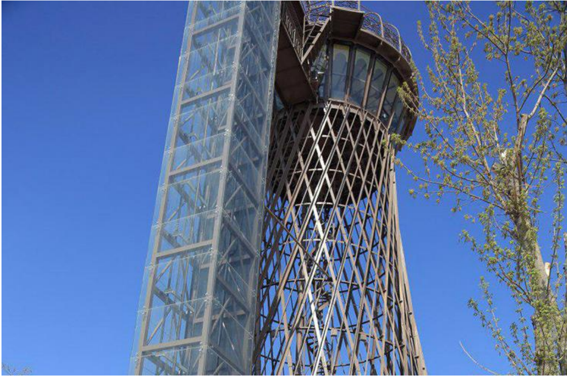
Рисунок 2 – Общий вид конструкций водонапорной башни в г. Бухара после восстановления
