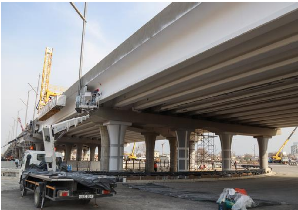
Рисунок 3 – Строительство верхнего уровня транспортной развязки
