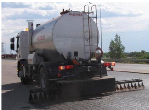
Рисунок 1 – Нанесение ГПС с низкой вязкостью с помощью автогудронатора
