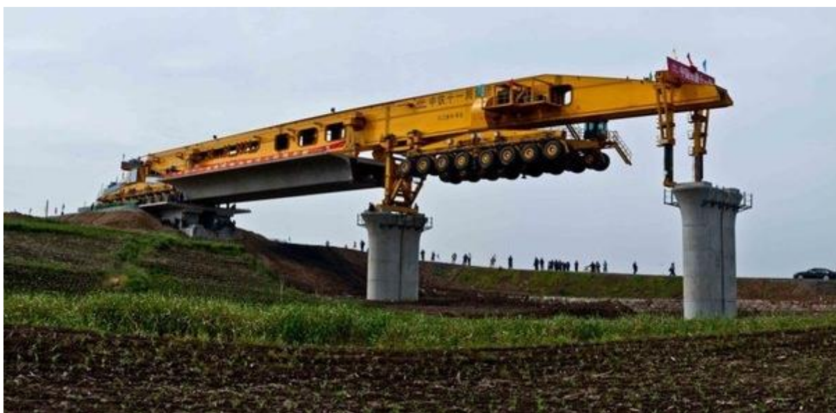
Рисунок 1 – Захват и надвижка балки пролетного строения
