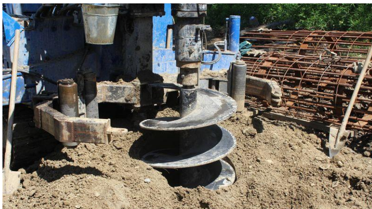
Рисунок 1 – Бурение скважины
