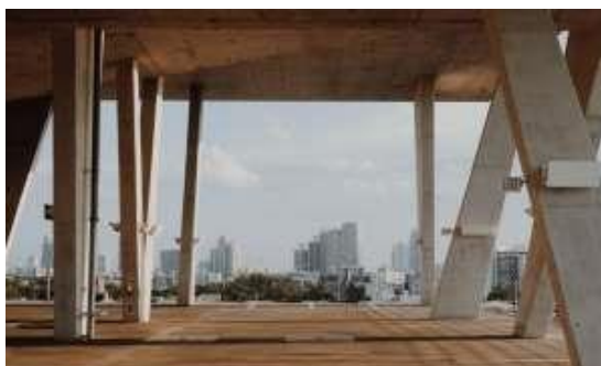
Рисунок 1 – Строение с использование бетона из графена
