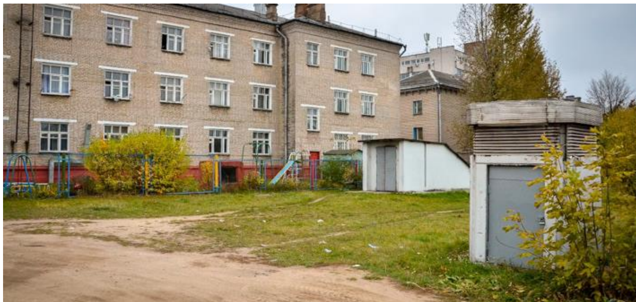
Рисунок 3 – Второй выход со станции «Пролетарская»
