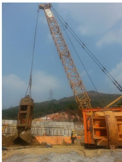
Рисунок 1 – Удаление лишнего грунта
