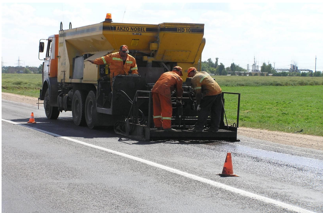
Рисунок 45 - Общий вид смесителя-укладчика HD-10
