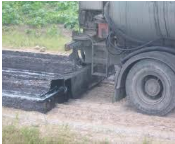
Рисунок 23 - Распределение битумной эмульсии автогудронатором при обеспыливании гравийных дорог
