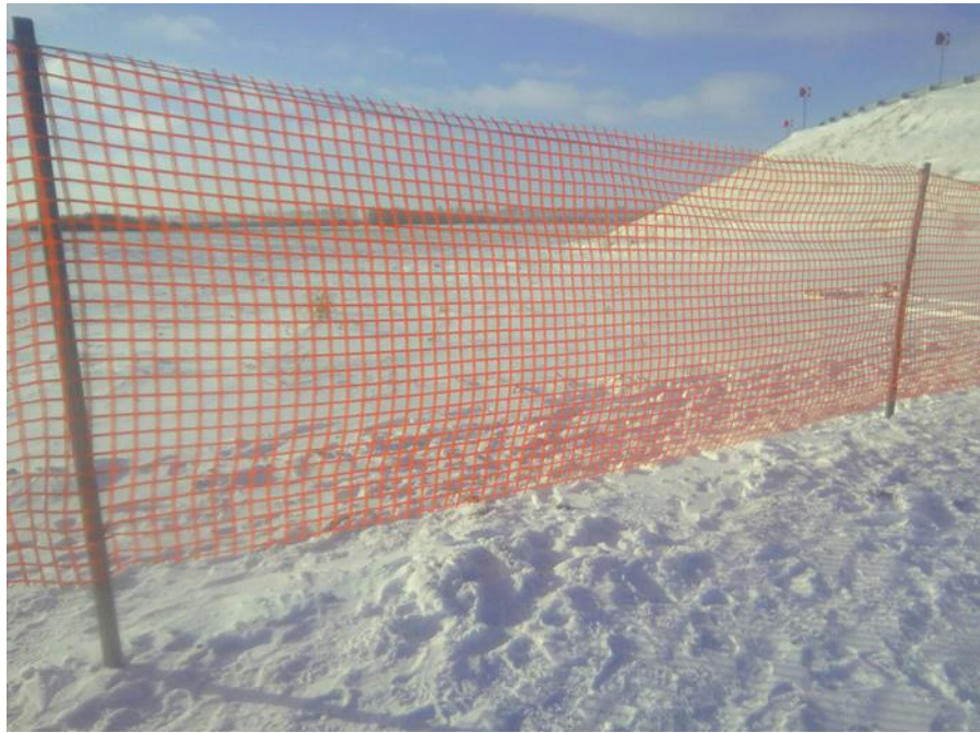
Рисунок 8 – Пример установки снегозадерживающих сооружений из полимерной сетки
