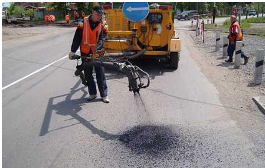
Рисунок 29 – Вид выбоины заделанной струйно-инъекционным способом
