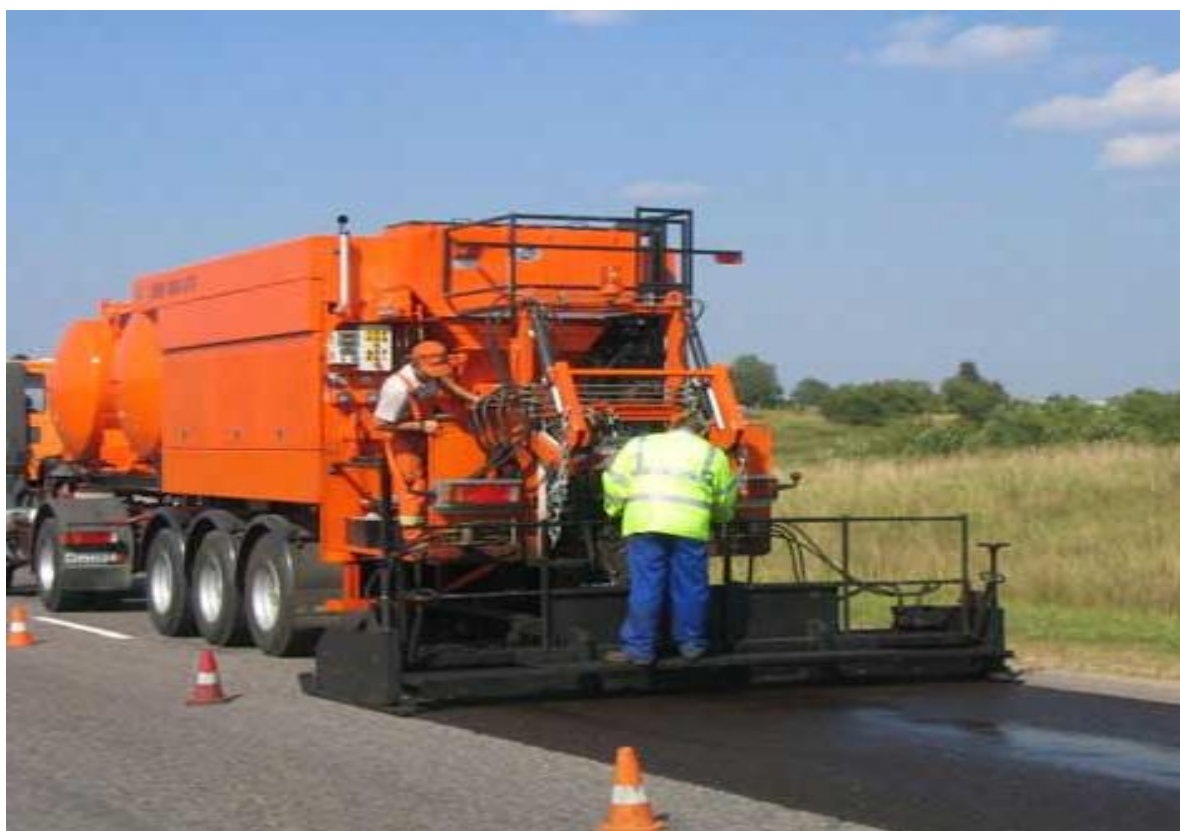
Рисунок 44 – Общий вид смесителя-укладчика WEIRO SOM-1000-3/10
