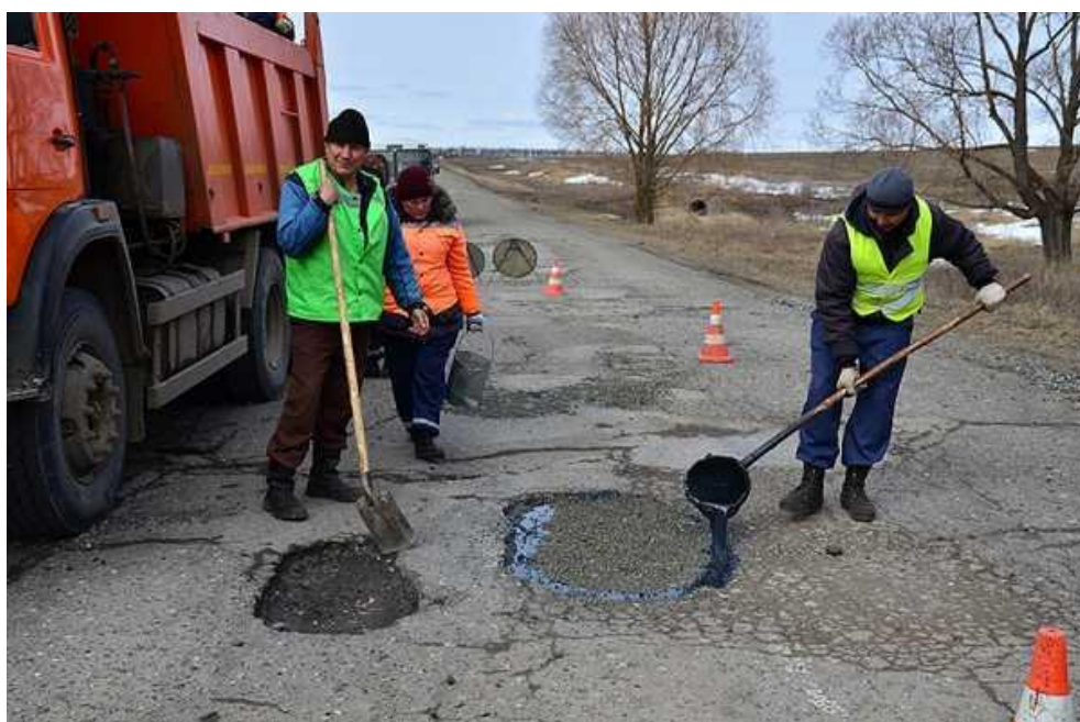
Рисунок 29 – Заделка выбоины способом пропитки
