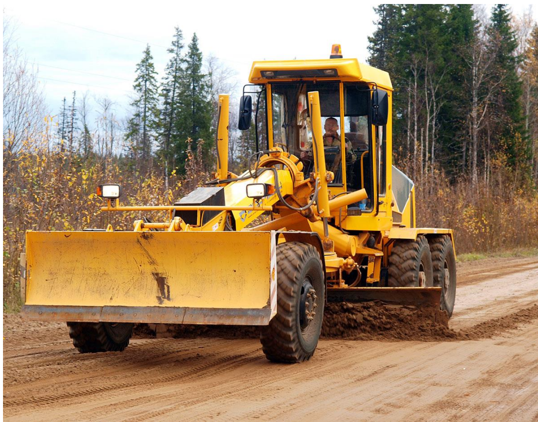
Рисунок 22 – Профилировка гравийного покрытия
