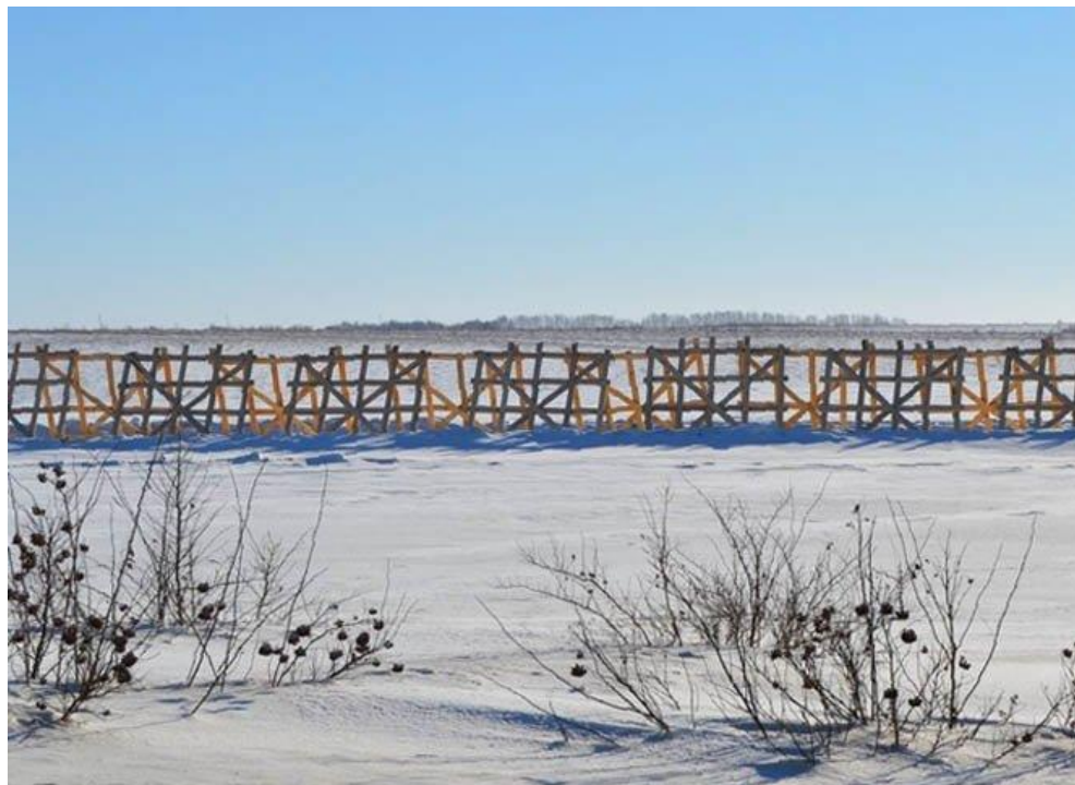
Рисунок 5 – Пример размещения снегозащитных щитов
