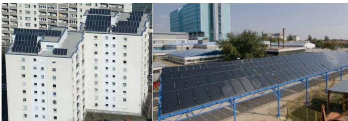
Рисунок 2 - Вариант размещения гелиоколлекторов а) в домах с ограничительным размером площади крыши, б) на металлической конструкции вблизи жилого дома
