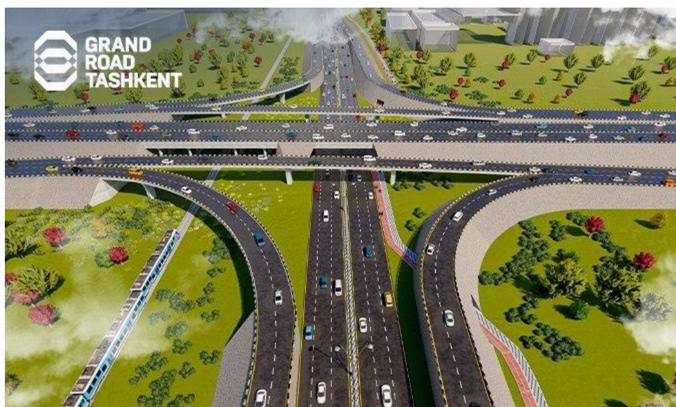
Рисунок 1 – Общий вид улучшенной ромбовидной транспортной развязки
