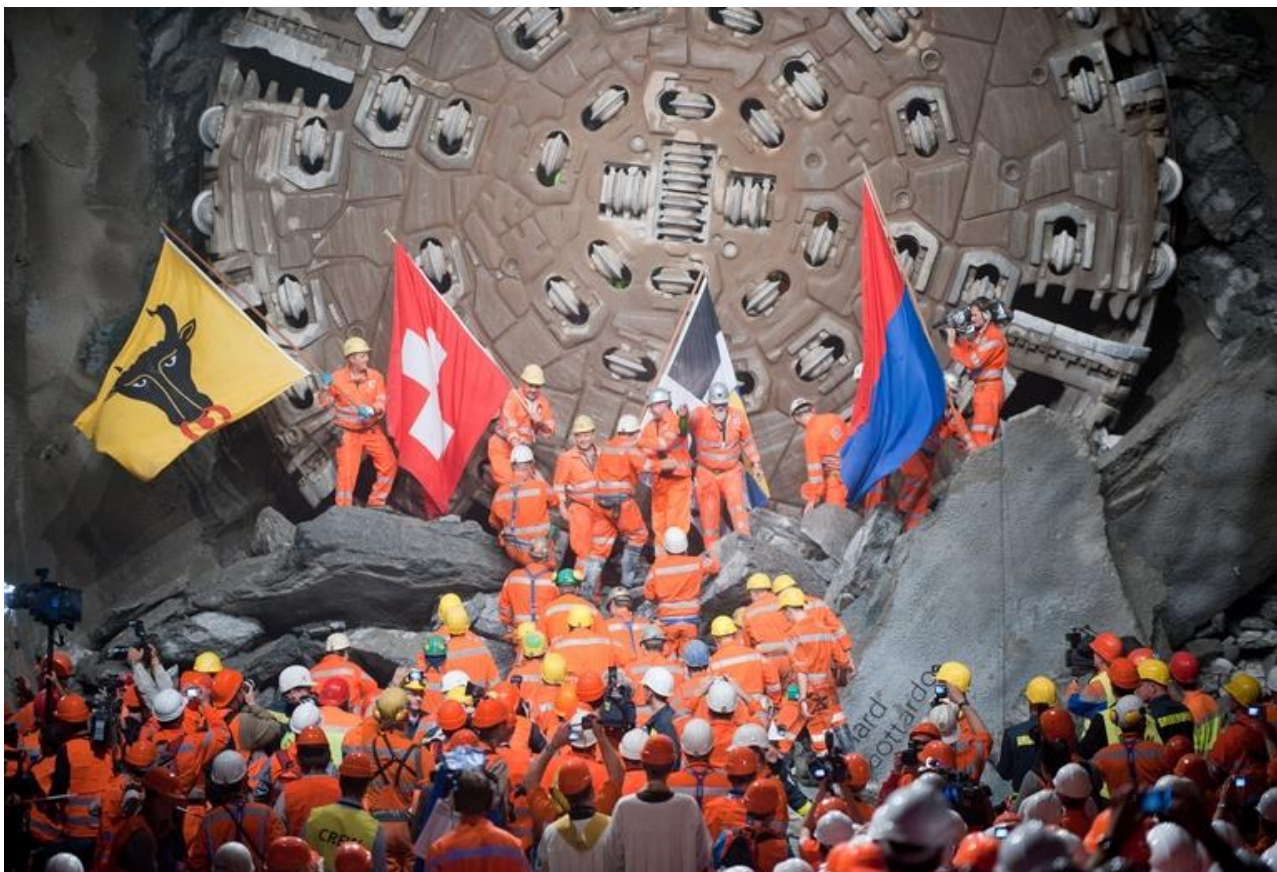
Рисунок 2 – Окончание работ по прокладке тоннеля
