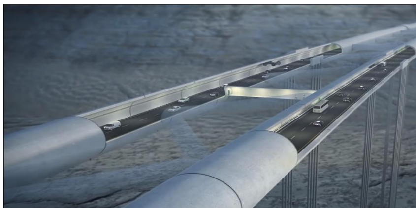
Рисунок 2 – расположения тоннельных труб
