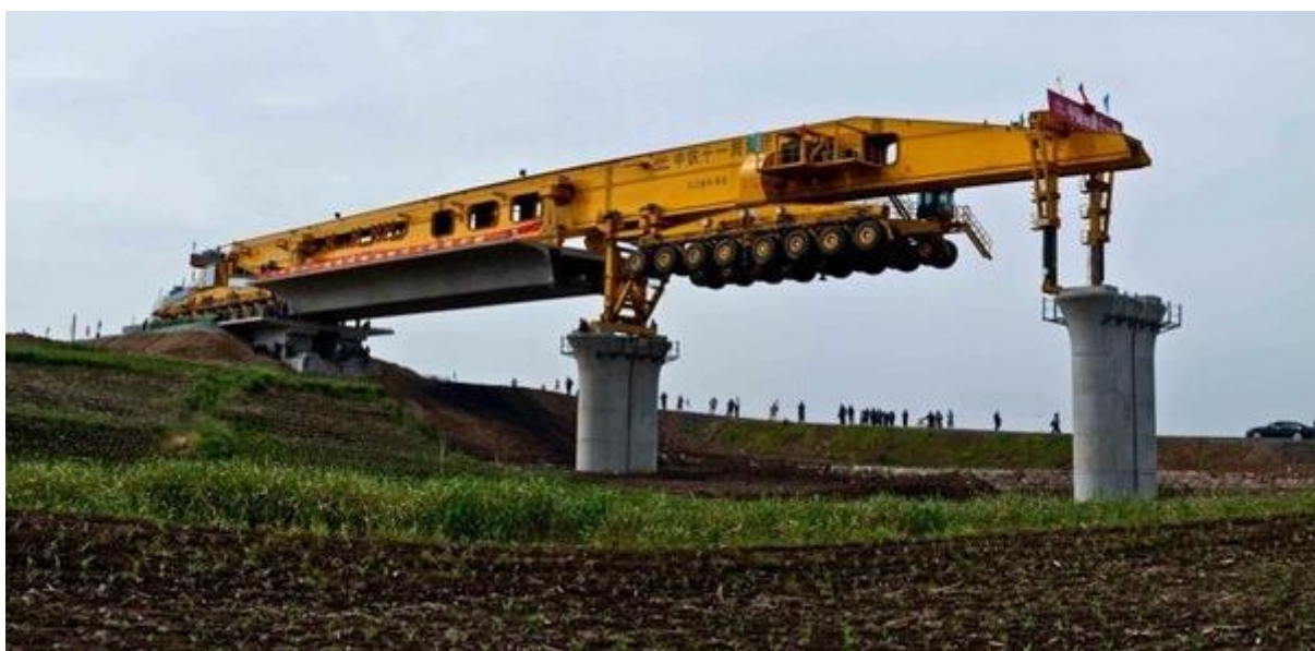
Рисунок 1 – Захват и надвижка балки пролетного строения
