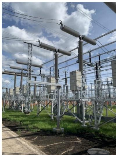
Рисунок 7 – Выключатель – разъединитель
