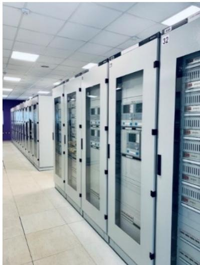
Рисунок 6 – Синхронизаторы времени
