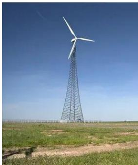
Рисунок 1. Первая промышленная ВЭУ в стране NORDEX 29/250 мощностью 250 кВт,
