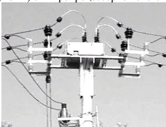
Рисунок 1 – Высоковольтный модуль реклоузера РВА/TEL "Таврида Электрик"
