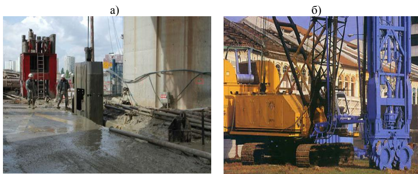
Рис. 6. Навесное оборудование для устройства траншейных стен в грунте:
