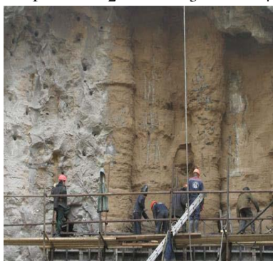
Рис. 13. Ограждение котлована, выполняемое с применением струйной технологии [2]
