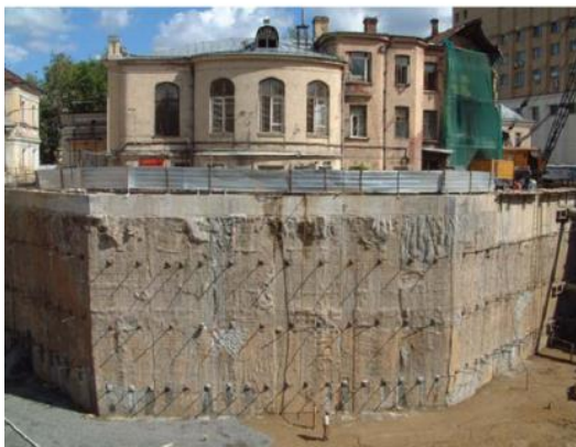
Рис. 4. Крепление котлована монолитными траншейными стенами:
