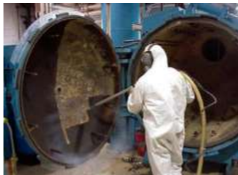
Рис. 1. Очистка вакуумной камеры механическим методом
