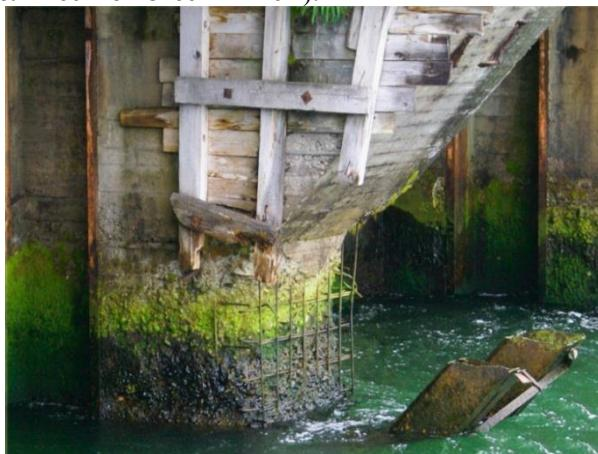
Рисунок 3. Коррозия железобетона в зоне переменного уровня морской воды
