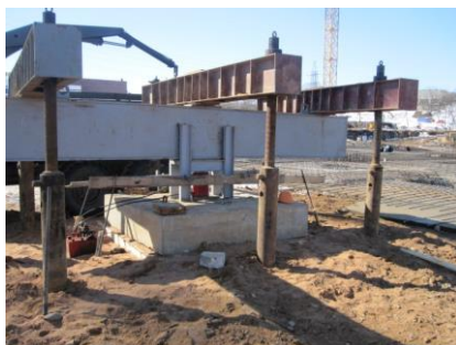
Рис. 1. Опытный фундамент и упорная конструкция
