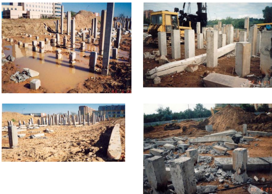
Рис. 1. Примеры свайных лесов (непогруженные на проектные глубины сваи)
