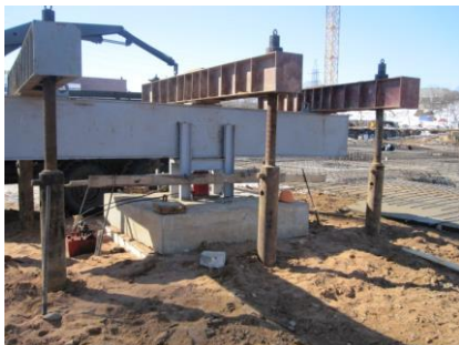
Рис. 1. Опытный фундамент и упорная конструкция
