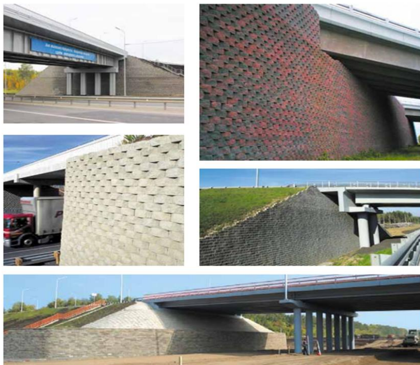
Рисунок 1. – Применение армогрунтовых стен
