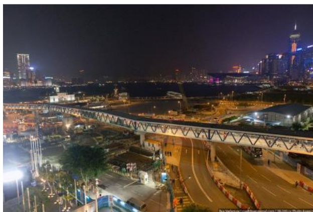
Рисунок 1. – Наземный пешеходный переход в г. Гонконг
