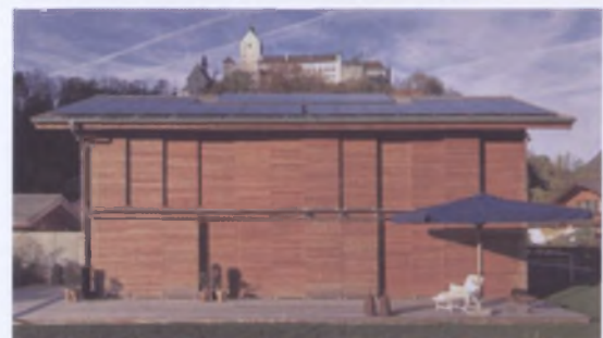
Рис. 3. Пример современного применения ставен. Двухэтажный жилой дом с раздвижными ставнями (архит. М. Майер, Германия)
