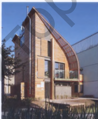
Рис. 7. Деревянное здание с использованием комплекса энергосберегающих и энергоэффективных технологий (архит. Ш. Робсон совместно с Arup&Kingspan)
