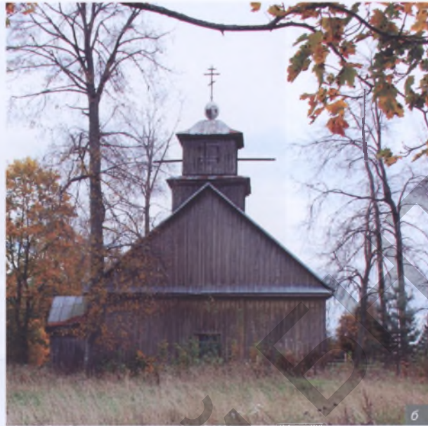
Мал. 5. Каркас з дрэва дазволіў выконваць ярусныя кампазіцыі званіц (а) і вежаў храмаў (б)
